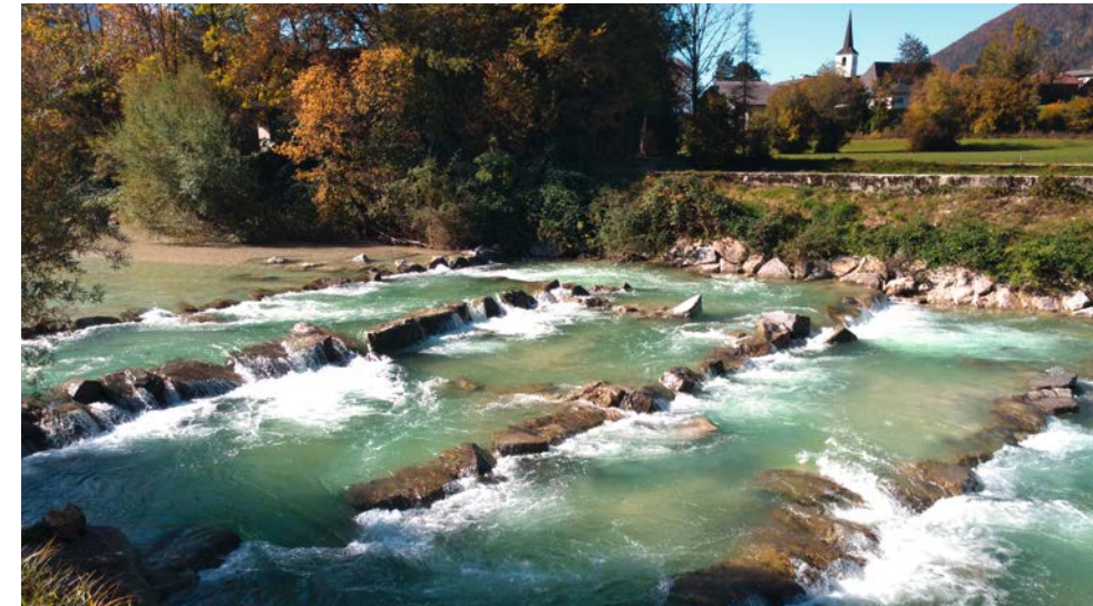
Aufgelöste Rampe an der Ager bei Vöcklabruck als naturnahe, für Fische und andere Organismen passierbare Alternative zum ursprünglich nicht passierbaren Absturzbauwerk
