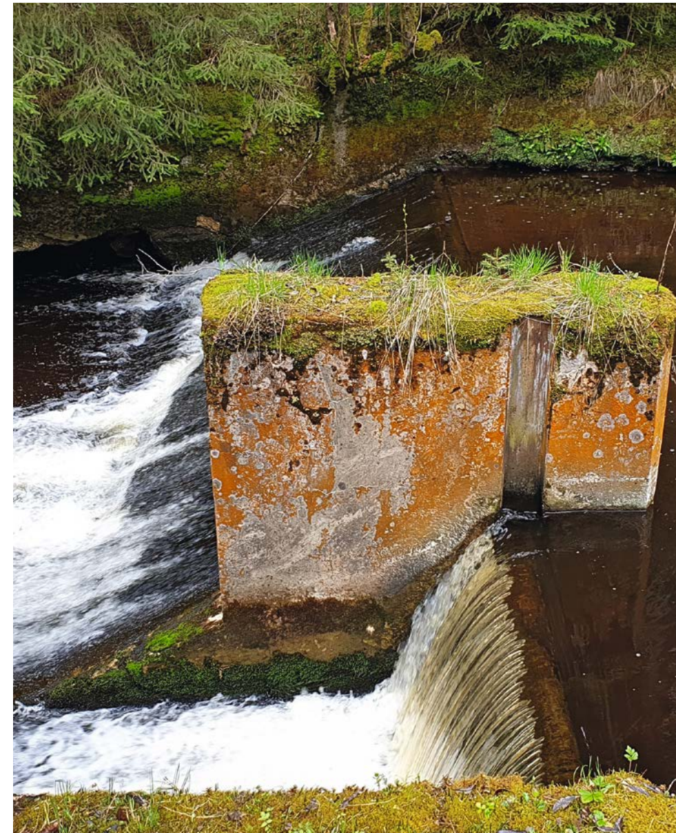
Detail des betonierten Querbauwerkes
