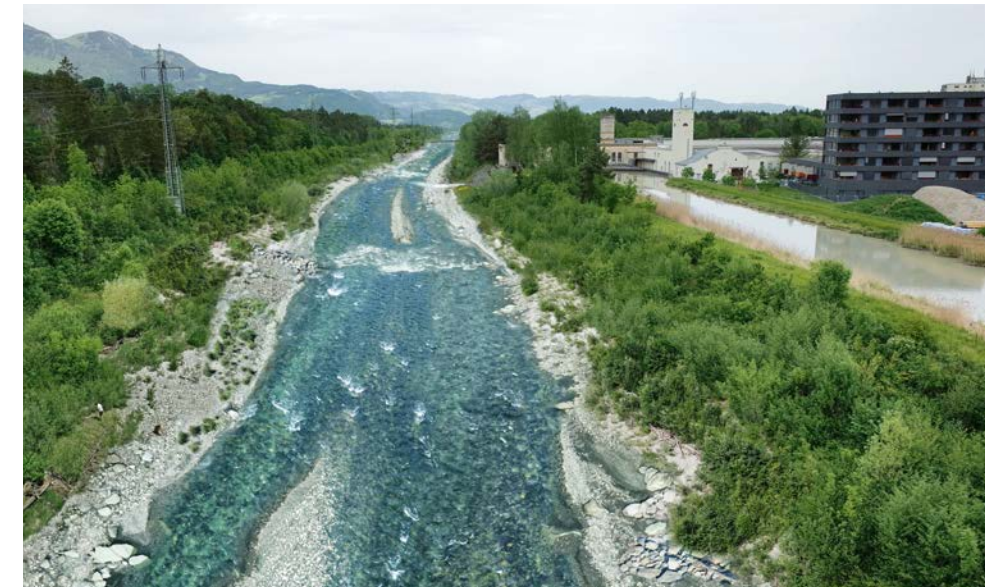
Visualisierung desselben Flussabschnittes nach Fertigstellung der Aufweitung
