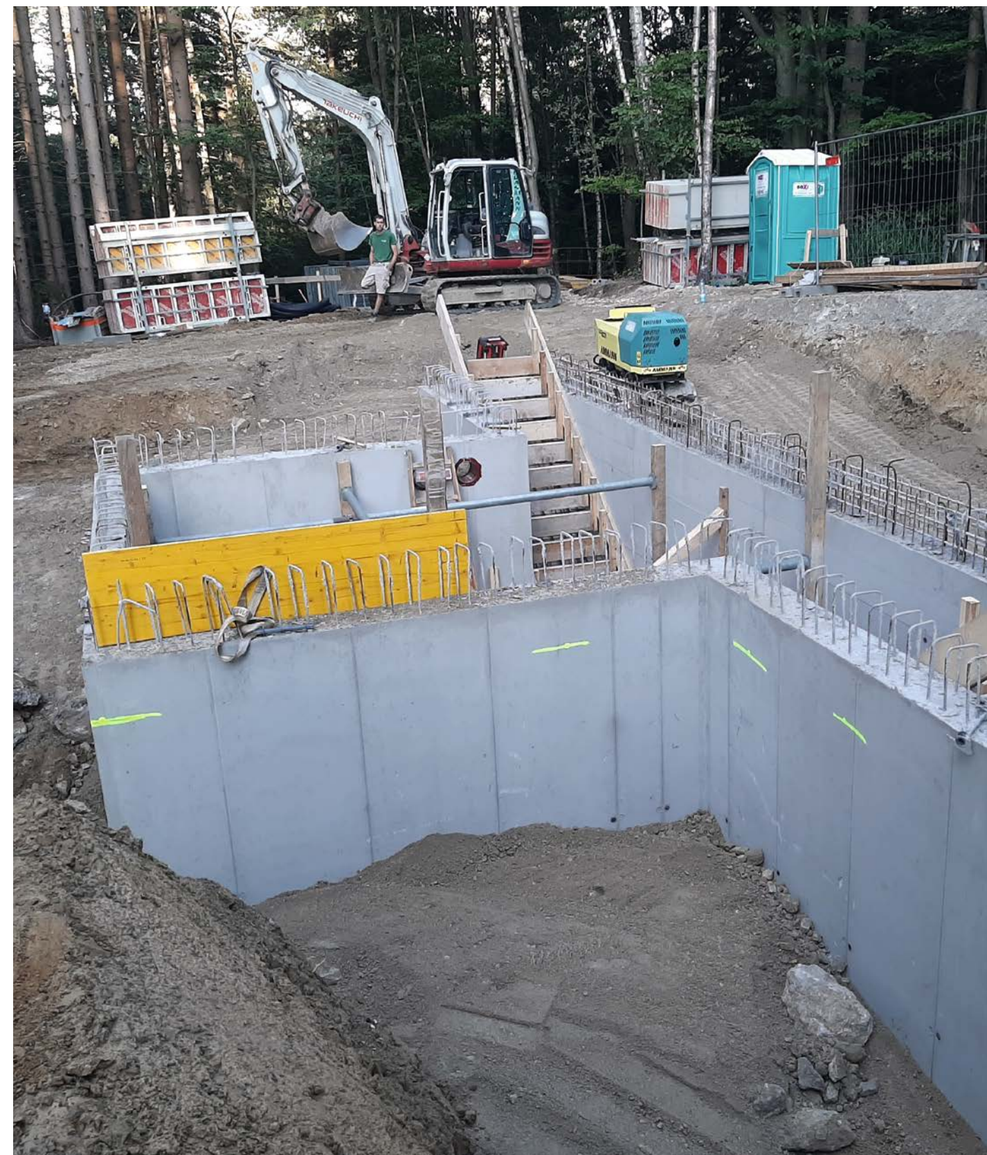
Schieberkammer Hochbehälter
